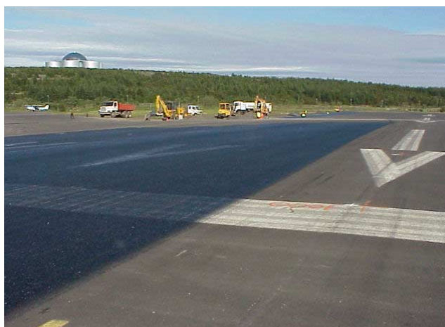
Mynd 10: Unnið við límingu milli malbikslaga
