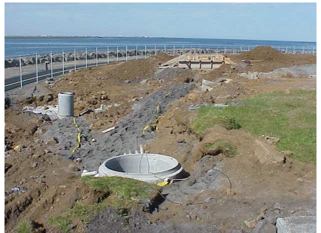
Mynd 18: Grunnur stefnuvitahúss og lagnir
