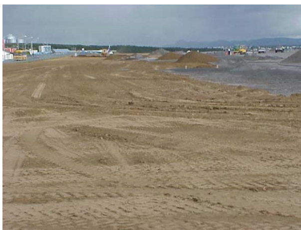
Mynd 11: Frágangur yfirborðsmoldar norðan flugbrautar
