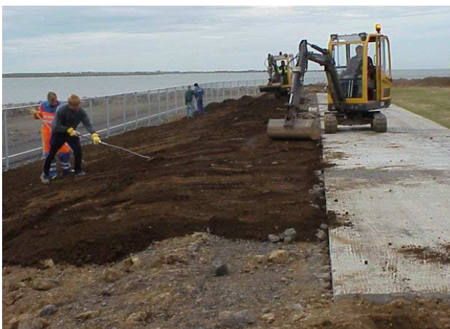
Mynd 19: Yfirborðsmold meðfram undirstöðu stefnuvita
