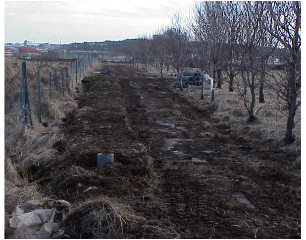
Mynd 16: Búið að koma fyrir rörum undir staura
