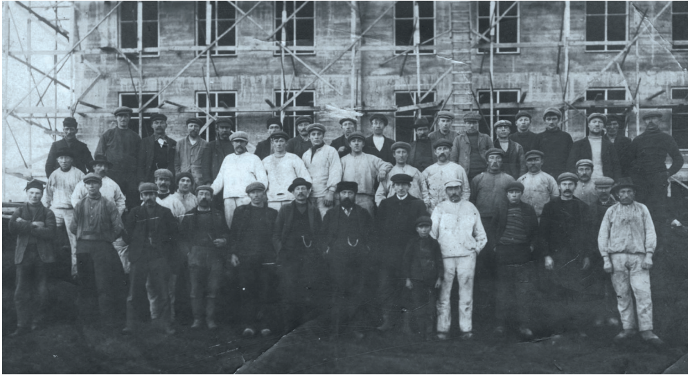
Starfsmenn við byggingu Vífilsstaðaspítala, 1909. Bygging spítalans tók um eitt ár. Rögvaldur Ólafsson sem er fyrir miðri mynd í fremstu röð teiknaði húsið.
